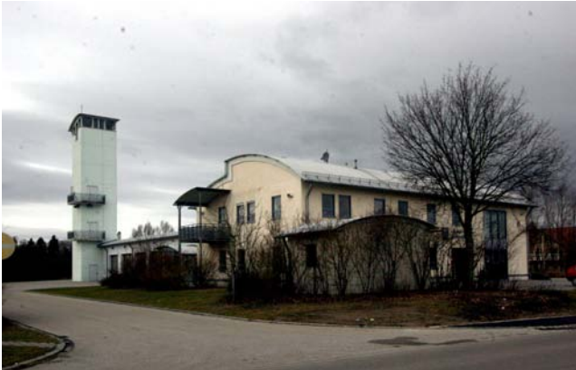
Feuerwehrhaus Reichertshofen vorher
