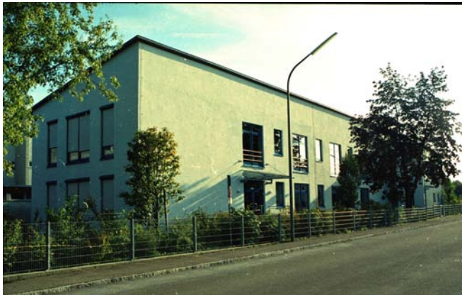
Grundschule Reichertshofen vorher
