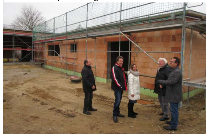
Georg Pfab, Erwin Strasser, Andrea Blößl, Elisabeth Großmann & Bgm. Michael Franken besichtigen den Rohbau
