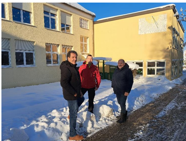
Brandschutzsanierung und LAN-Verkabelung Schule Langenbruck Kosten mind. 500.000 € (2025), Neubau Kita Spatzen- nest (2026); Kosten mind. 6 Mio. €;
